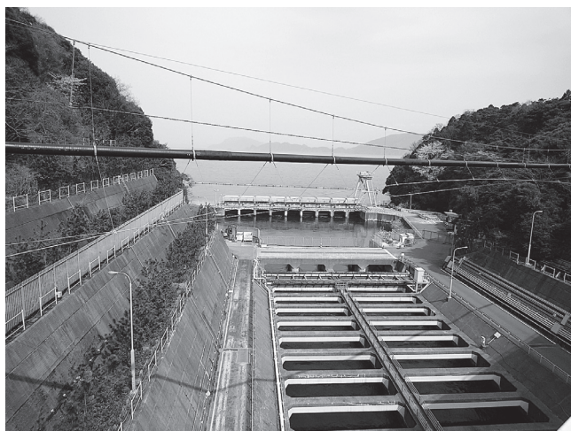
写真10 高浜原発の取水口
