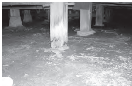
図表49 床下の腐朽
