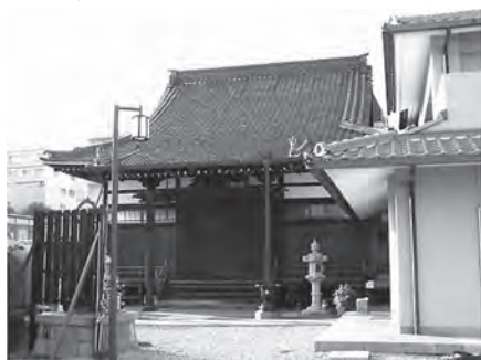
図表32 耐震補強 (No.1：誓願寺)
