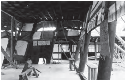
図表28 本住吉神社拝殿の傾斜・神戸市東灘区 (軸組の変形)
