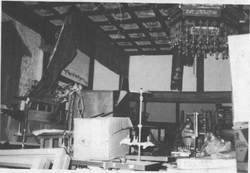
倉庫に使用されている某寺本堂
