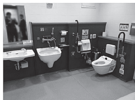
トイレの改修
