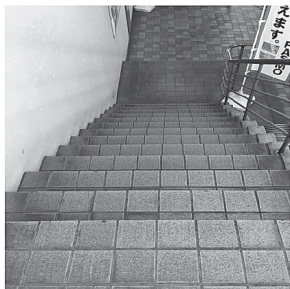
階段の段差を明示するため白色に塗装
