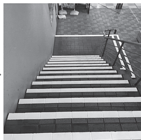
階段の段差を明示するため白色に塗装
