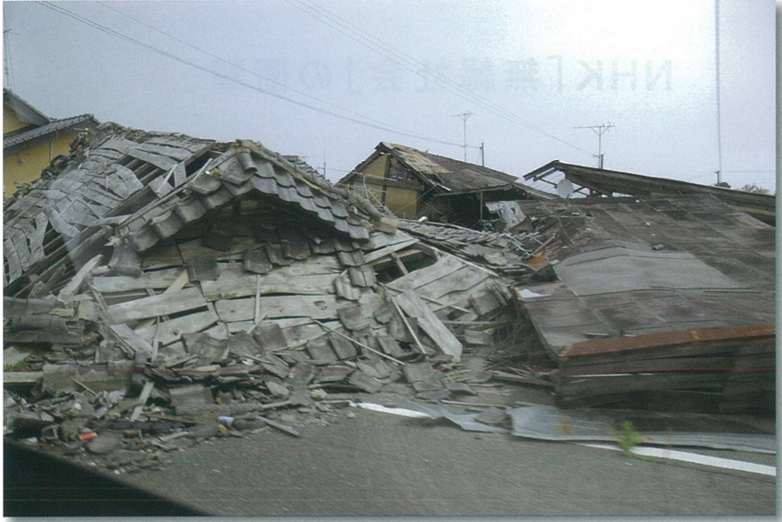
倒壊した福島県双葉町の街並(平成24年5月撮影)
