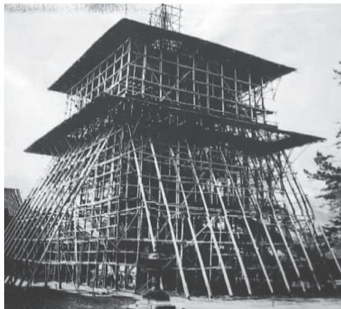
(図23) 法隆寺の解体疎開
